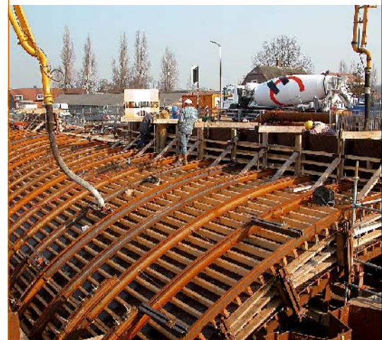
• Pompen/persen van mortel in tunneldek.
