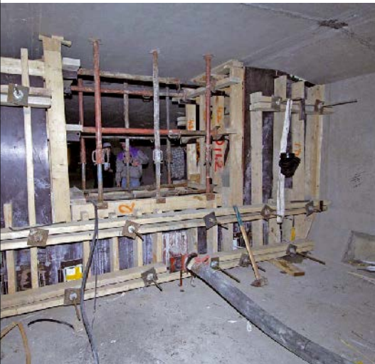
• Pompen/persen van mortel in wand.
